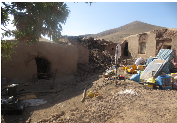
باز هم یک تصویر دلخراش از تخریبات زلزله در قریه خواجه قاسم ولسوالی کشک رباط سنگی ولایت هرات.
