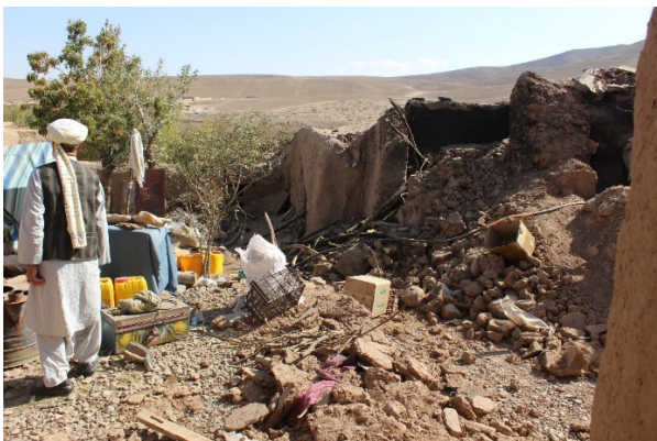
تصویر دلخراش از تخریبات زلزله در قریه خواجه قاسم ولسوالی کشک رباط سنگی ولایت هرات.
