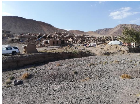
منازل تخریب شده قریه احمد آباد
